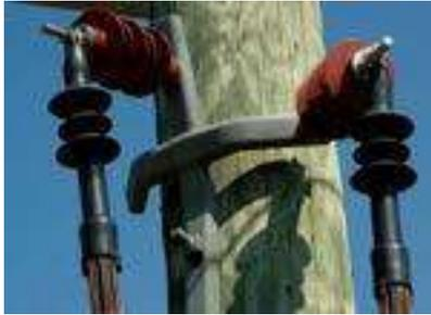
Fabricado en caucho (hule) siliconado con excelentes propiedades mecánicas, hidrofóbicas, aislantes y de resistencia a los rayos UV y a las descargas superficiales, disponible hasta 35 kV.
